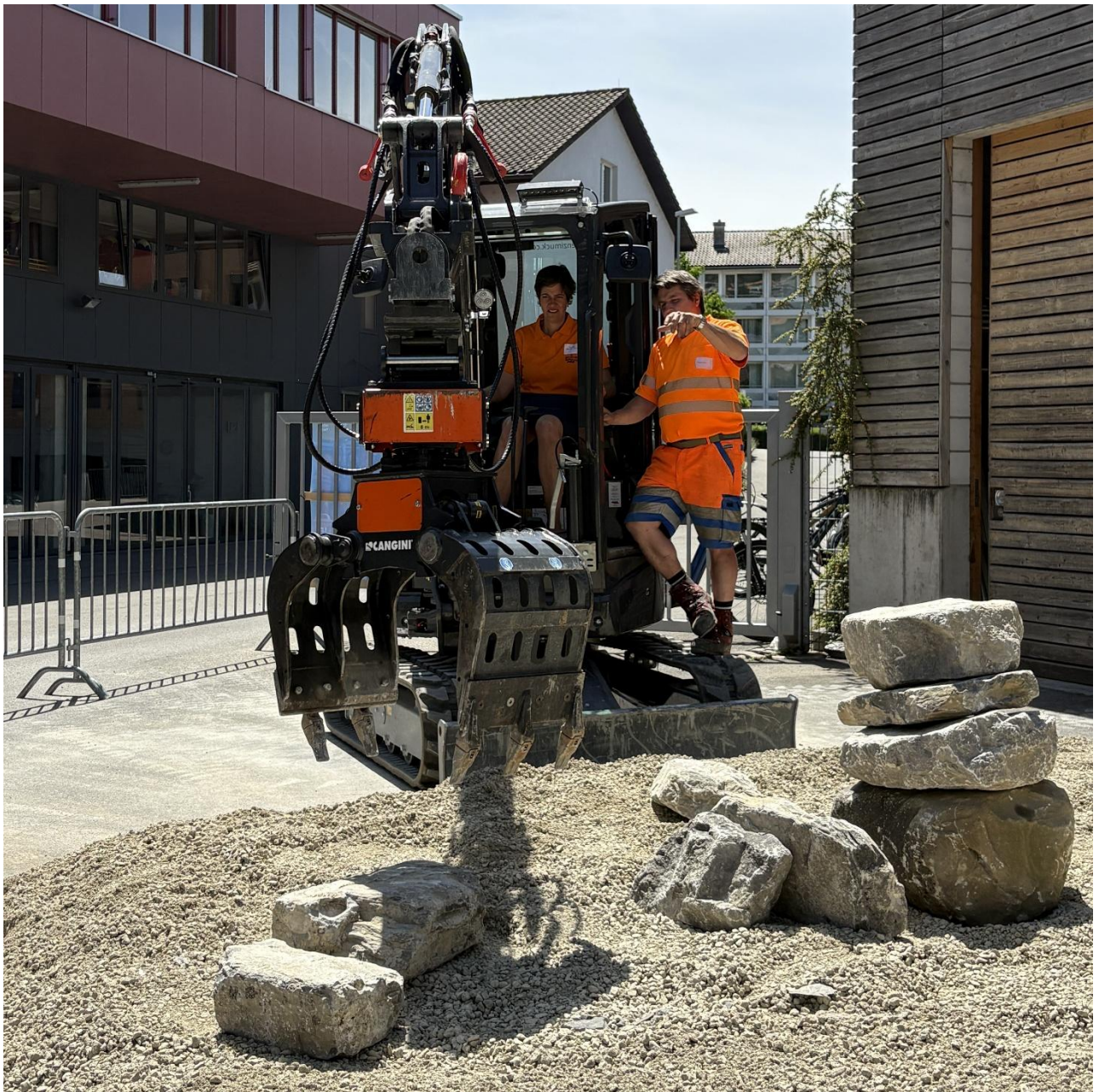
Abb 2: Die Bedienung der Baggerschaufel erfordert viel Fingerspitzengefühl
