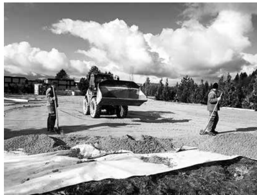
Vorbereitungsarbeiten für Zeltbau der Oberländer Märlibühni
